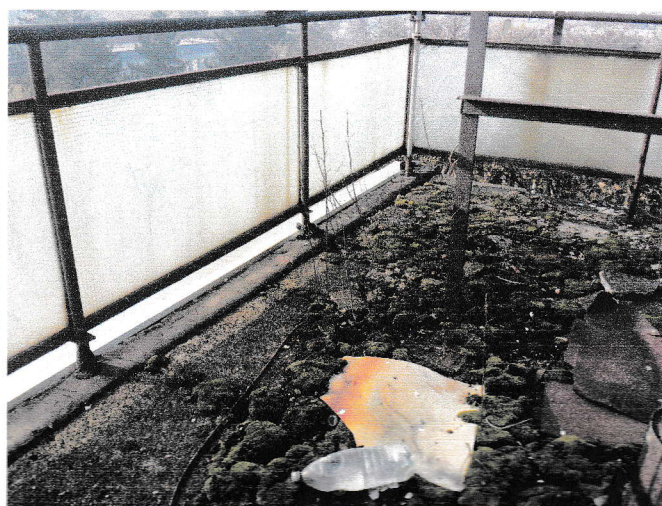
8 STANJE HIDROIZOLACIJE RAVNOG KROVA ZGRADE
