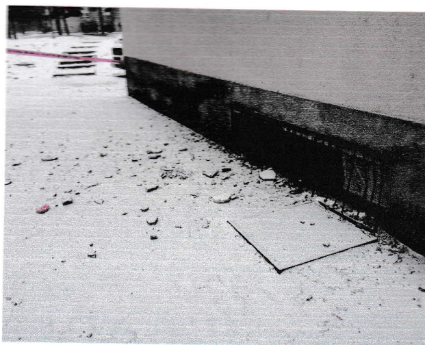
17. DELOVI OTPALE FASADE PREMA ULICI (24.01.2016)
